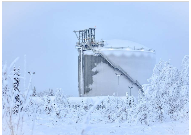
LNG Storage Tank
